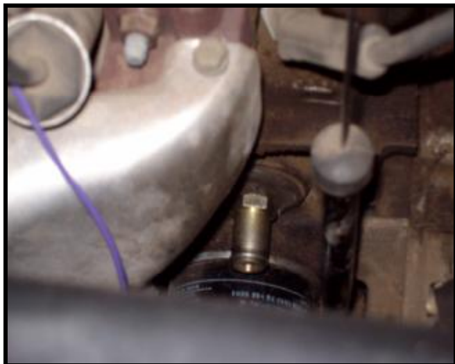
Рис. 1. Монтаж заглушки и штуцера К1/4".
