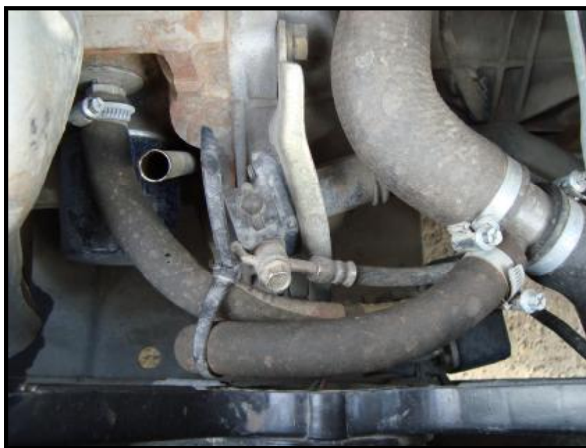
Рис. 3. Монтаж входного и выходного рукава, тройника Ø35×16×35.
