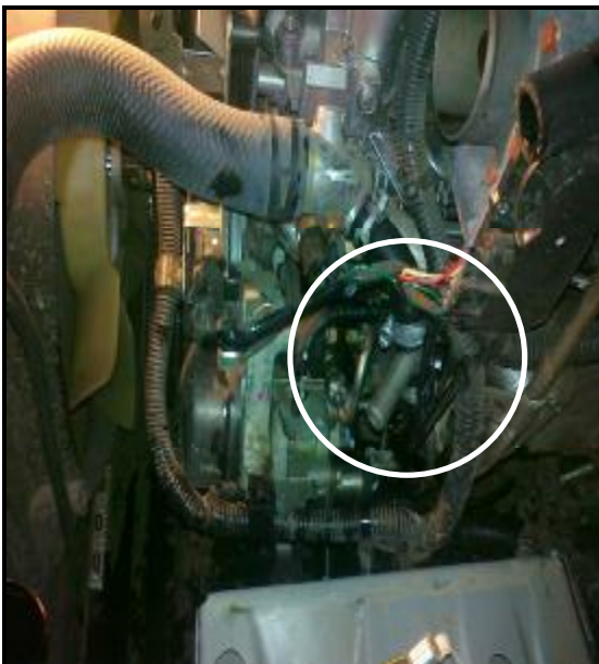
Рис.5 Монтаж тройника 16x16x16
