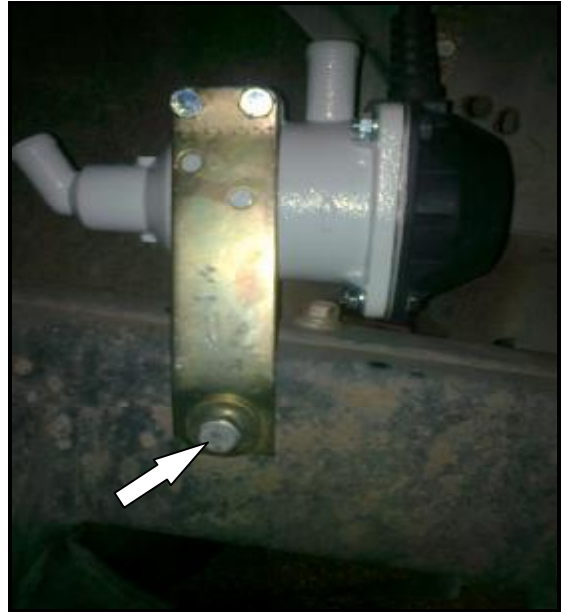
Рис.2 Монтаж подогревателя на раме
