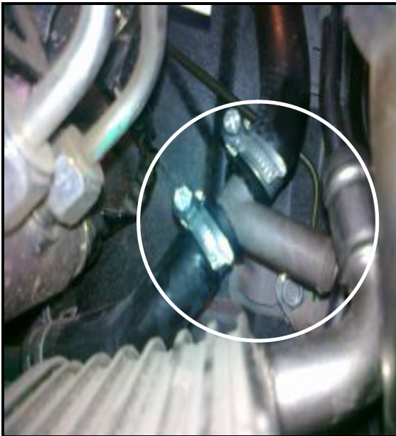
Рис.3 Монтаж тройника 16x16x16
