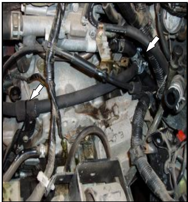
Рис.1 монтаж тройника 19x16 и способ его фиксации
