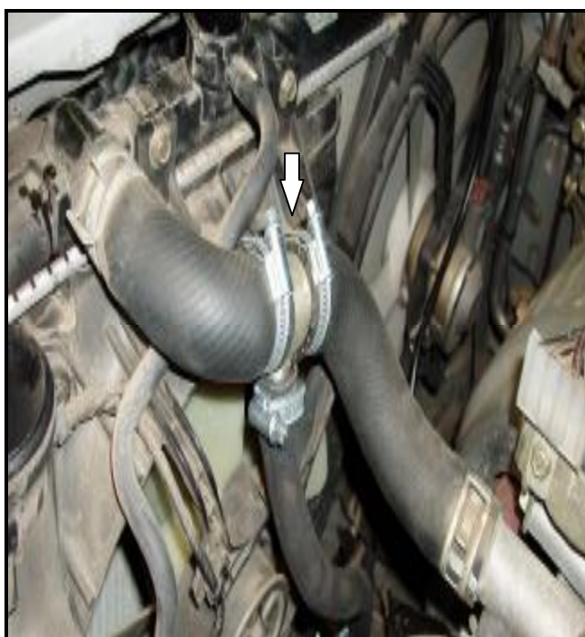
Рис. 2 монтаж тройника 28x16
