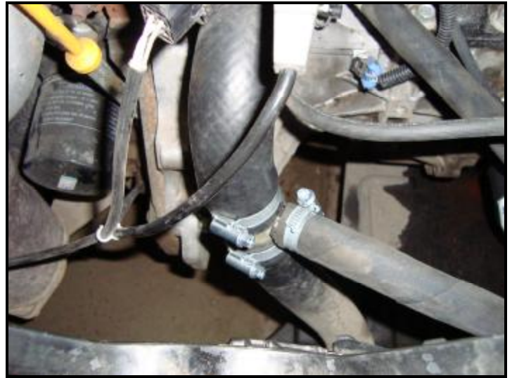
Рис.2. Монтаж тройника Ø35 мм, входного рукава.
