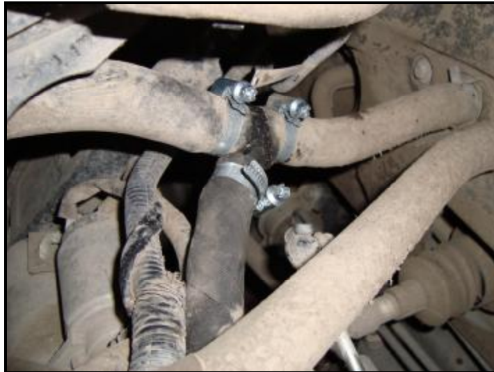
Рис.3. Монтаж тройника Ø19×16 мм и выходного рукава.
