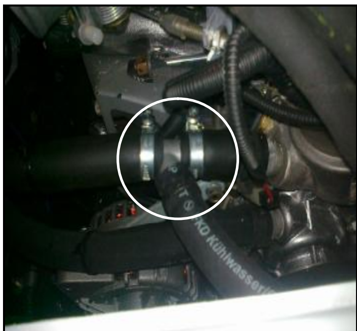
Рис.3 Монтаж тройника 19x19x 16, выходного рукава
