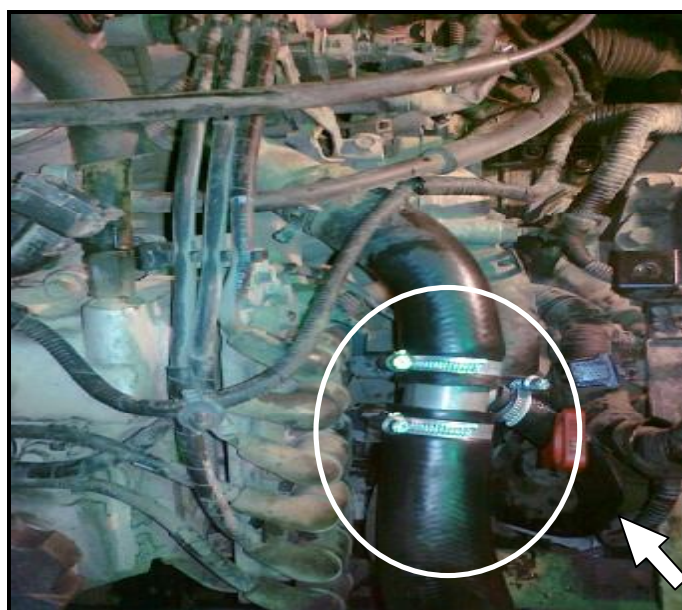
Рис.5 Монтаж тройника 35x35x16 и положение выходного рукава
