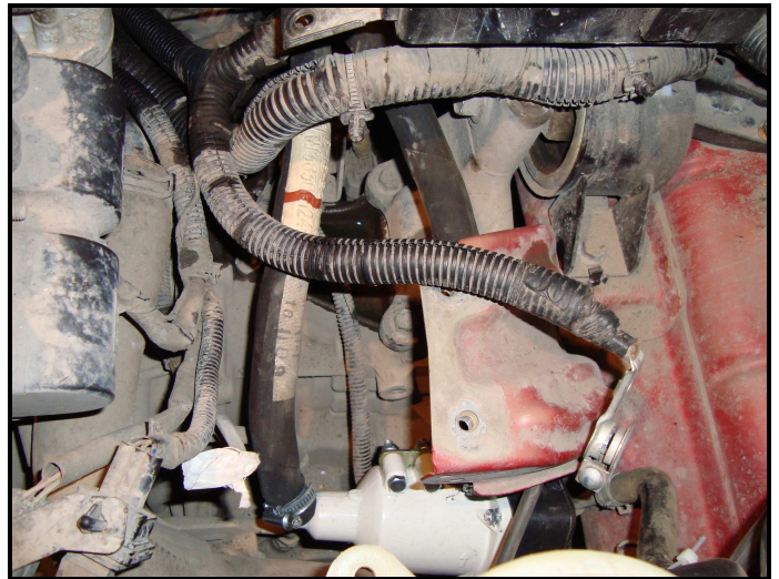
Рис.2. Монтаж электроподогревателя и рукавов.
