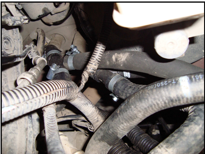
Рис.3. Монтаж тройников \text{Ø}19 \times 16 \times 19 , входного и выходного рукава.
