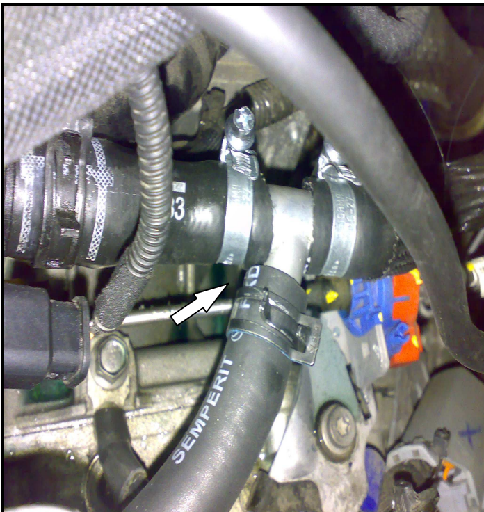
Рис.3 Монтаж тройника 19x16x19
