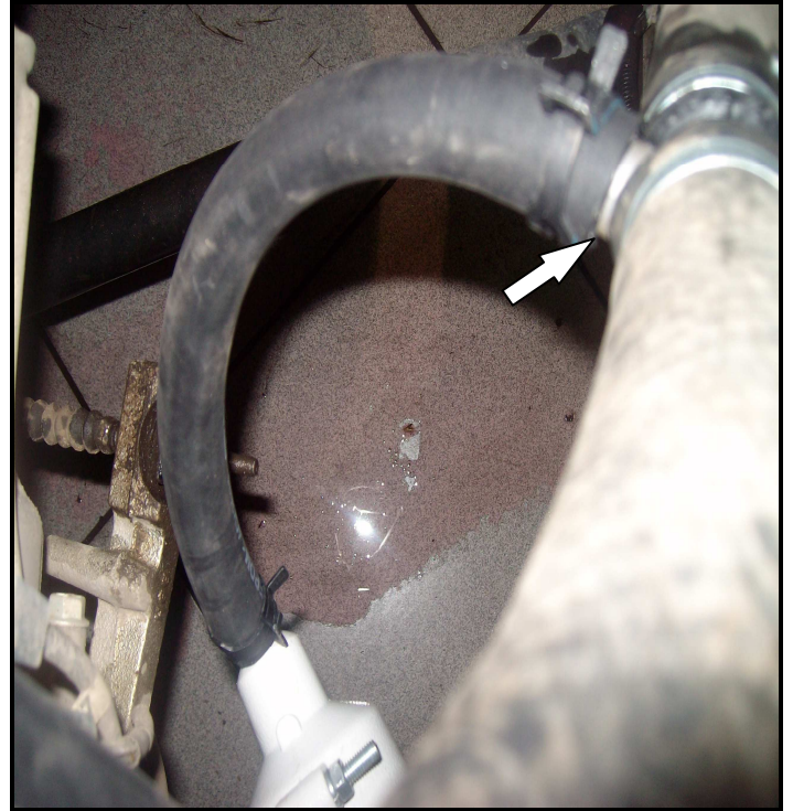
Рис. 3 Монтаж тройника 28x16x28
