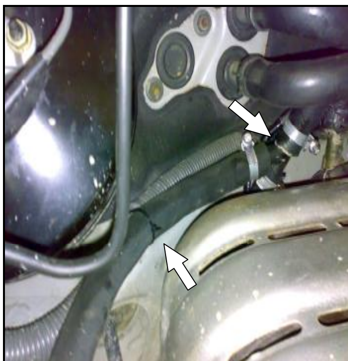
Рис. 3 монтаж тройника и фиксация рукава
