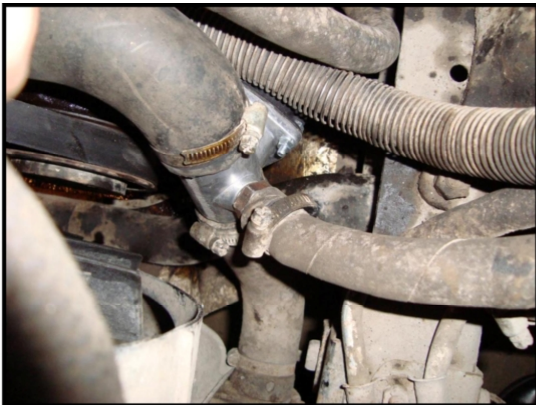
Рис.3. Монтаж подогревателя на автомобилях марки ГАЗ «Газель», ГАЗ «Соболь»
